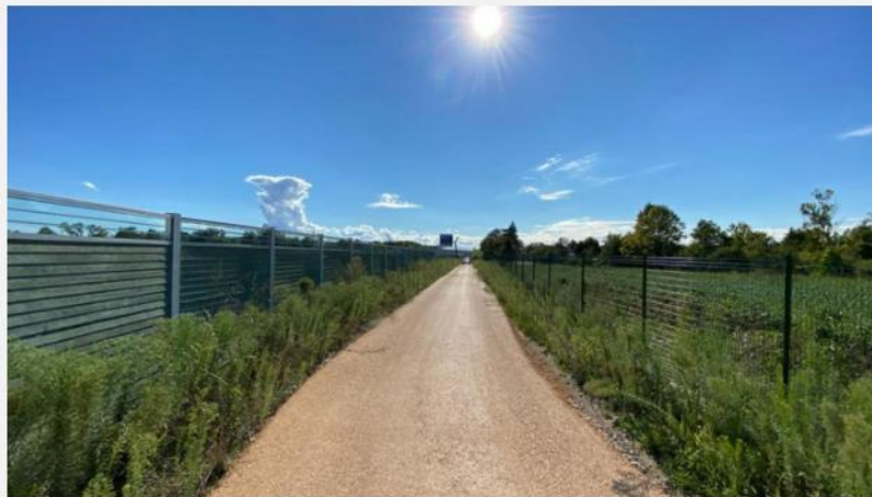
Castions di Strada, Italie – 55 kilomètres de stabilisation de la route
