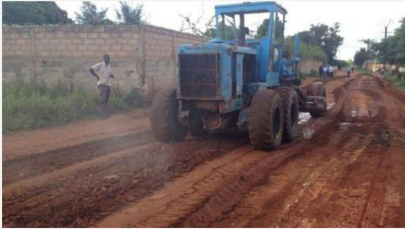
Sénégal, Afrique – Stabilisé six (6) kilomètres de route villageoise
