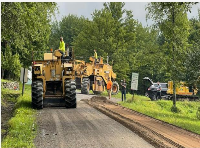
Comté de Chenango, NY – Route stabilisée + Scellée par éclat
