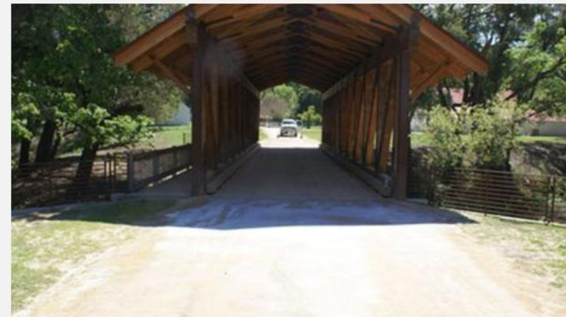
Los Alamos, CA – Route stabilisée + surface agrégée encastrée
