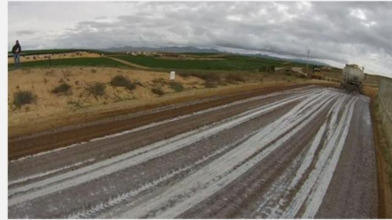
Fort Collins, CO – Route de campagne, deux (2) miles de stabilisation routière
